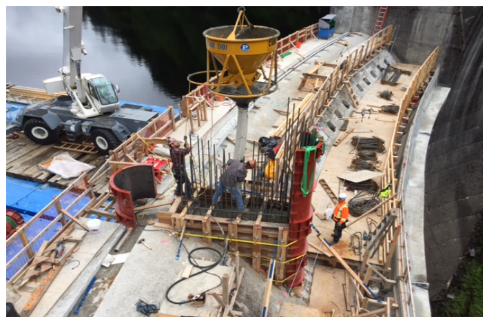
Middle Pier - First Concrete Pour
