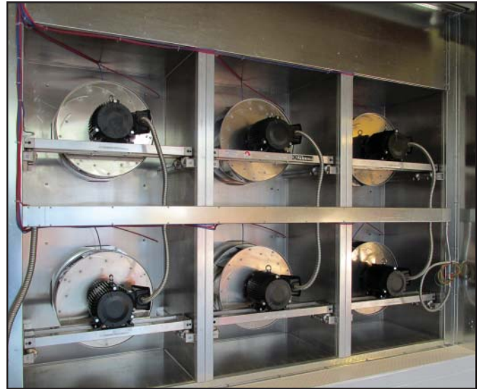
FAN / MOTOR ARRANGEMENT
